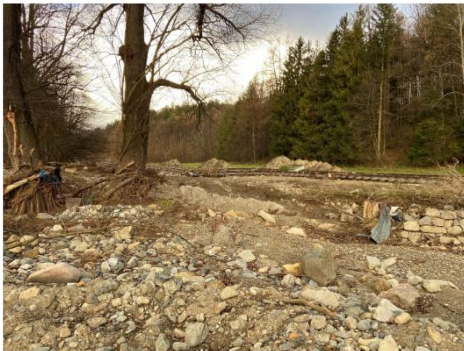
Obrázek 5 - poškozený násep bezprostředně pod sledovaným propustkem
